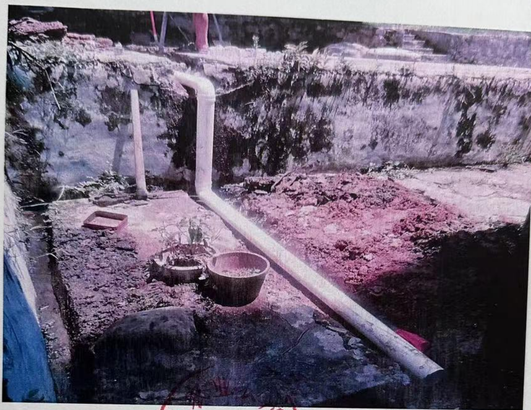
(三) 施工中：工人正在挖掘开沟安装排污管（下半段）
