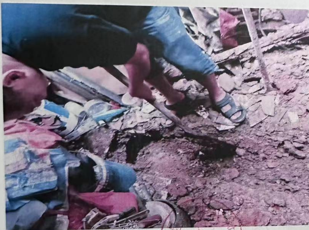
(三) 工人正在挖掘、清理堵塞排水管道
