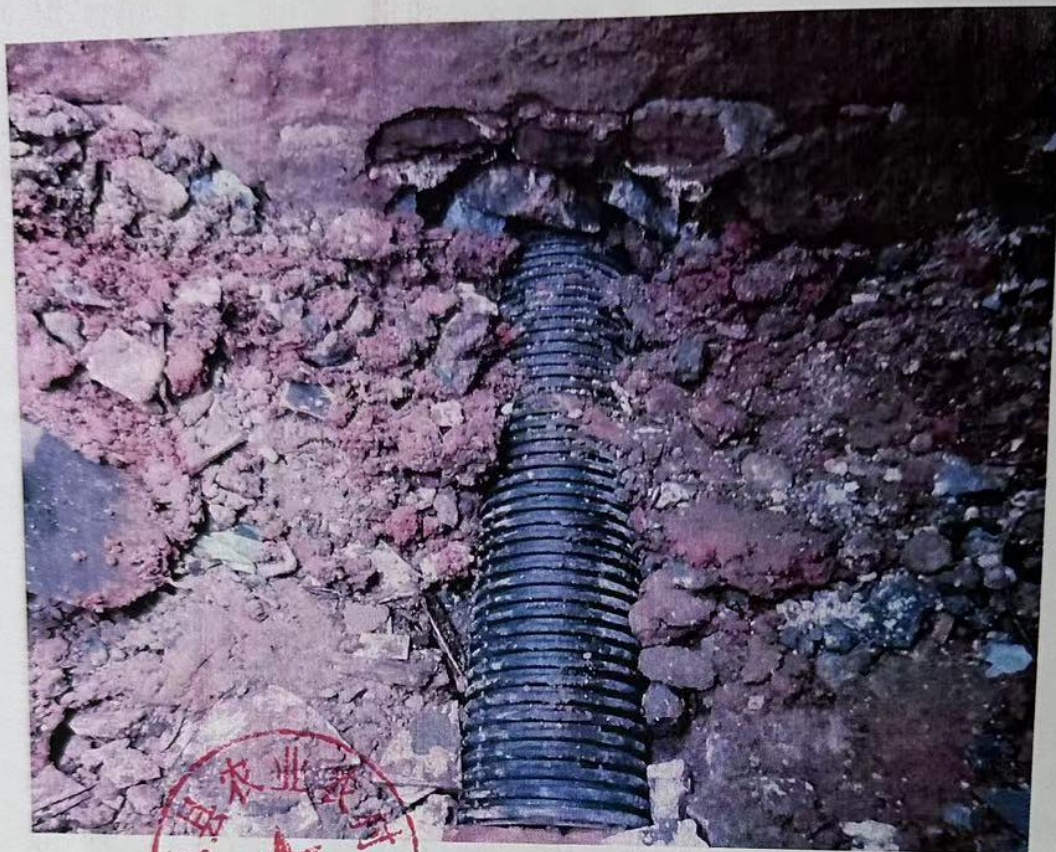
(五)工人正在铺设排污软管
